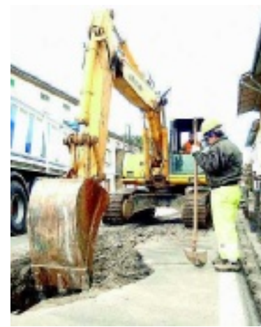
r.m. CANTIERI Condotte del gas
